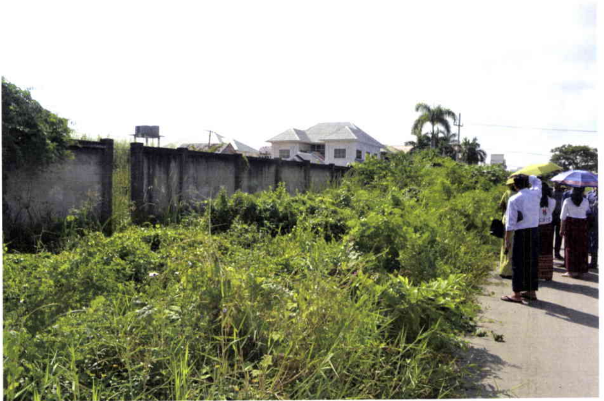
ချမ်းမြသာစည်မြို့နယ်၊ မြို့သစ်(၁)ရပ်ကွက်၊ ဖေလမ်း၊ ရွှေနှင်းဆီလမ်းနှင့် ယုဇနလမ်းကြား၊ အကွက်အမှတ် (၀၈-၇/၈)ဦးပိုင်အမှတ်(၁၄)မြေကွက်အား အဖွဲ့မှ စစ်ဆေးပုံ
